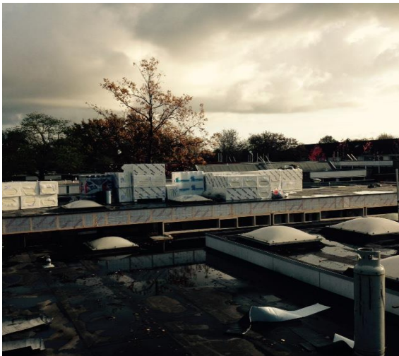
Het dak krijgt isolatie en nieuwe dakbedekking.....
